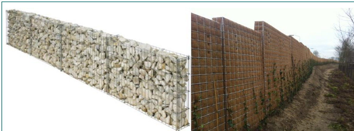
Figuur 3.2 Voorbeelden van schermen. Links een grindkorf en rechts een grondkorf.
